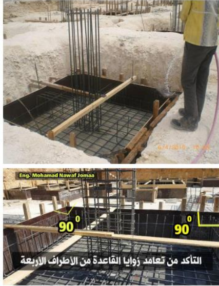
شكل (7): تجهيز القاعدة قبل الصب. [11]
