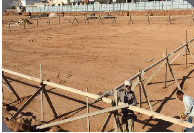
شكل (2): توقيع الخنزيرة في على ارض بعد عملية الحفر. [10]
