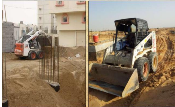
شكل (9): أعمال الردم للوصول إلى منسوب التشطيب. [8]
