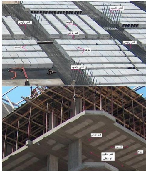
شكل (12): تنفيذ السقف. [9]
