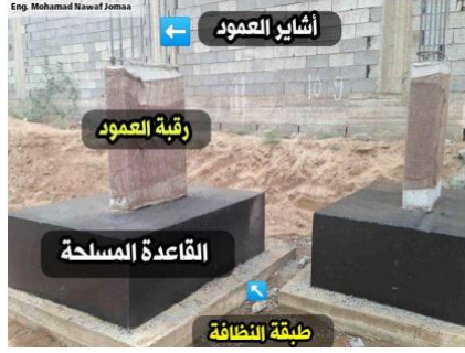
شكل (8): تفاصيل القواعد حتى الوصول إلى منسوب التشطيب. [11]
