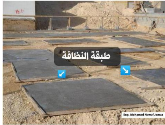
شكل (4): تنفيذ طبقة النظافة تحت القواعد. [11]
