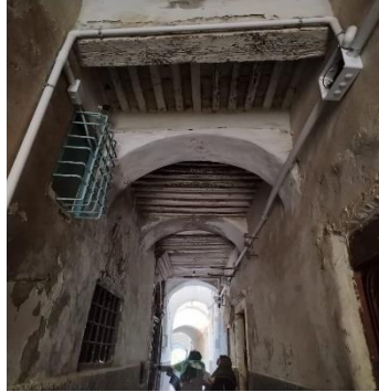
شكل رقم (12): التسقيف الخشبي لساباط زنقة بيت المال المصدر: تصوير الباحثة
