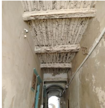
شكل رقم (11): التسقيف الخشبي لساباط زنقة بيت المال المصدر: تصوير الباحثة
