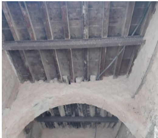
شكل رقم (3): التسقيف الخشبي لساباط زنقة حواء عليجة المصدر: تصوير الباحثة
