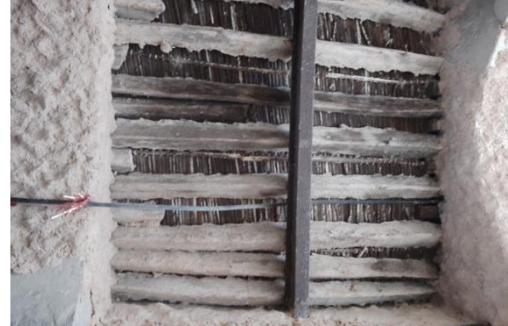
شكل رقم (4): التسقيف بجذوع النخيل والجريد المصدر: تصوير الباحثة
