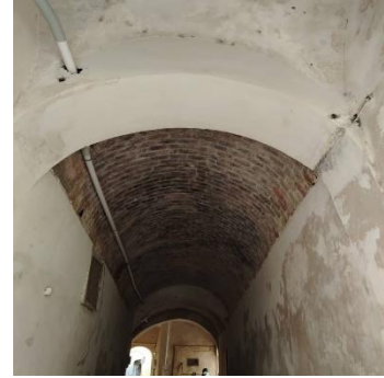
شكل رقم (17): تسقيف قبو متقاطع المصدر: تصوير الباحثة
