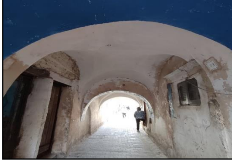
شكل رقم (8): استخدام التسقيف القبوي المصدر: عمل الباحثة
